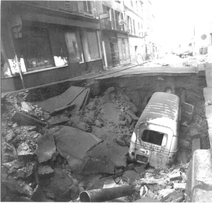
L'effondrement de la rue Boucicaut
