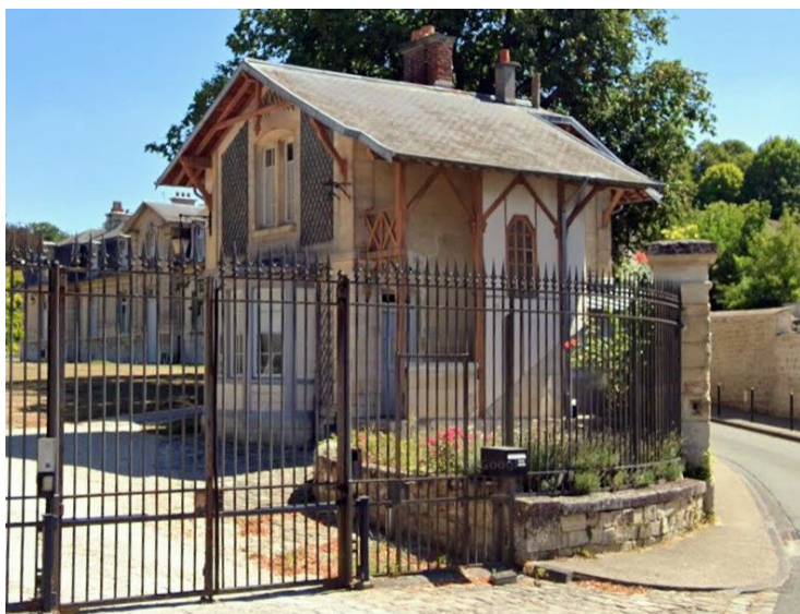
La petite maison du château de Nointel
